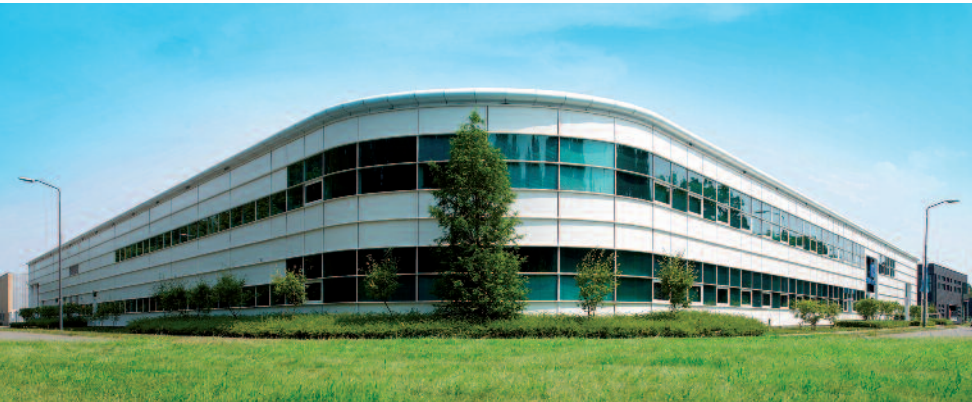
IGS GeboJagama kan de klant bijna de complete validatie van diens productieproces uit handen nemen. In het pand in Eindhoven komt hiervoor een apart customer service centre. Foto: IGS GeboJagama
